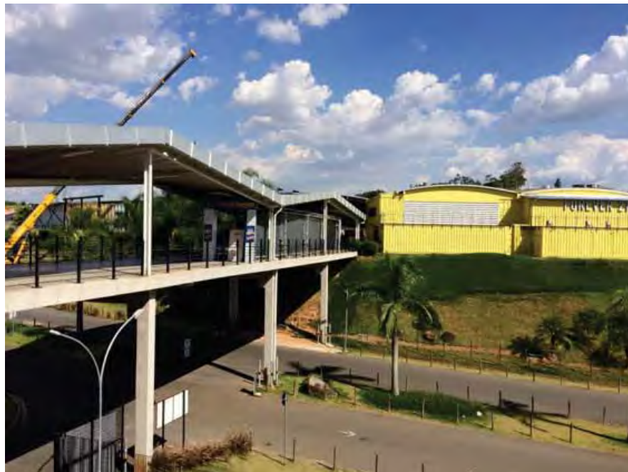
PASSARELA DE ACESSO AO ESTACIONAMENTO COBERTO
