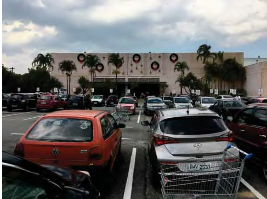
FACHADA DO IMÓVEL E VISTA DO ESTACIONAMENTO
