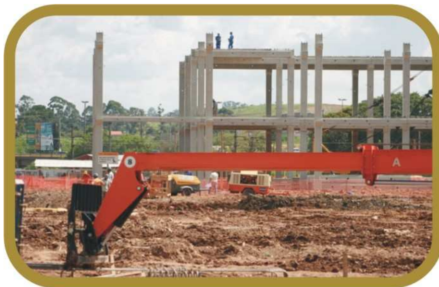
Obras em fevereiro de 2011
