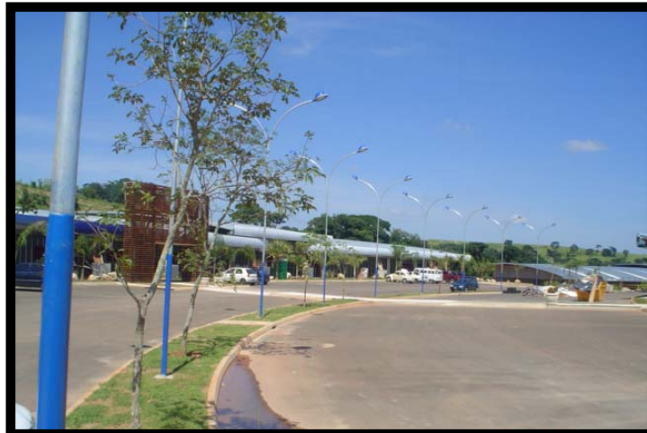
Obras dos Lojistas
