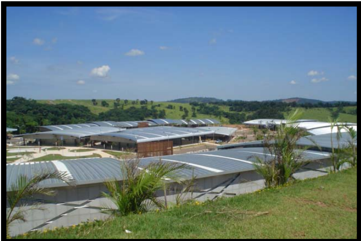
Vista Geral Leste
